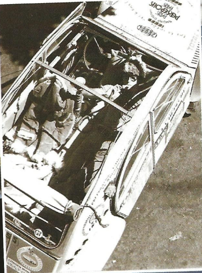
L'ingénieux système élaboré par Pierre et Jean-Paul permet de se reposer dans la 2 CV, allongé de tout son long et siège passager PO basculé vers l'avant, pendant que l'autre équipier conduit.
